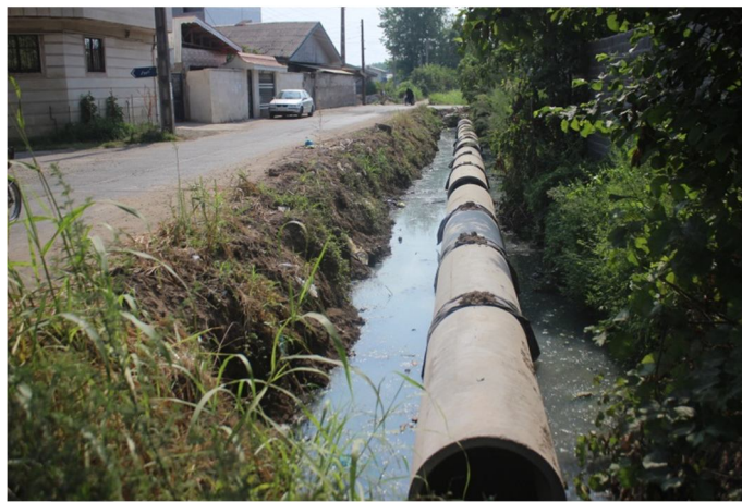
لوله گذاری و هدایت آبهای سطحی در خیابان بعثت - خیابان علوی در محله آخوندمزار
